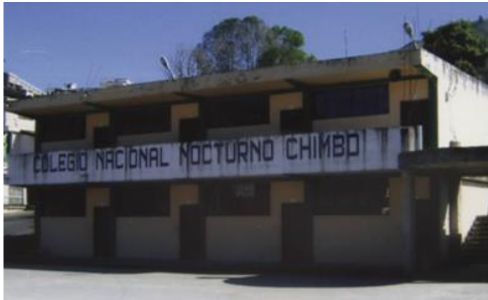
Edificio del Colegio Fiscal Nocturno “Chimbo”.
