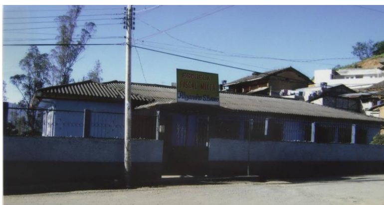
Edificio de la Escuela Fiscal “Alejandro Sergio Bermeo”.
