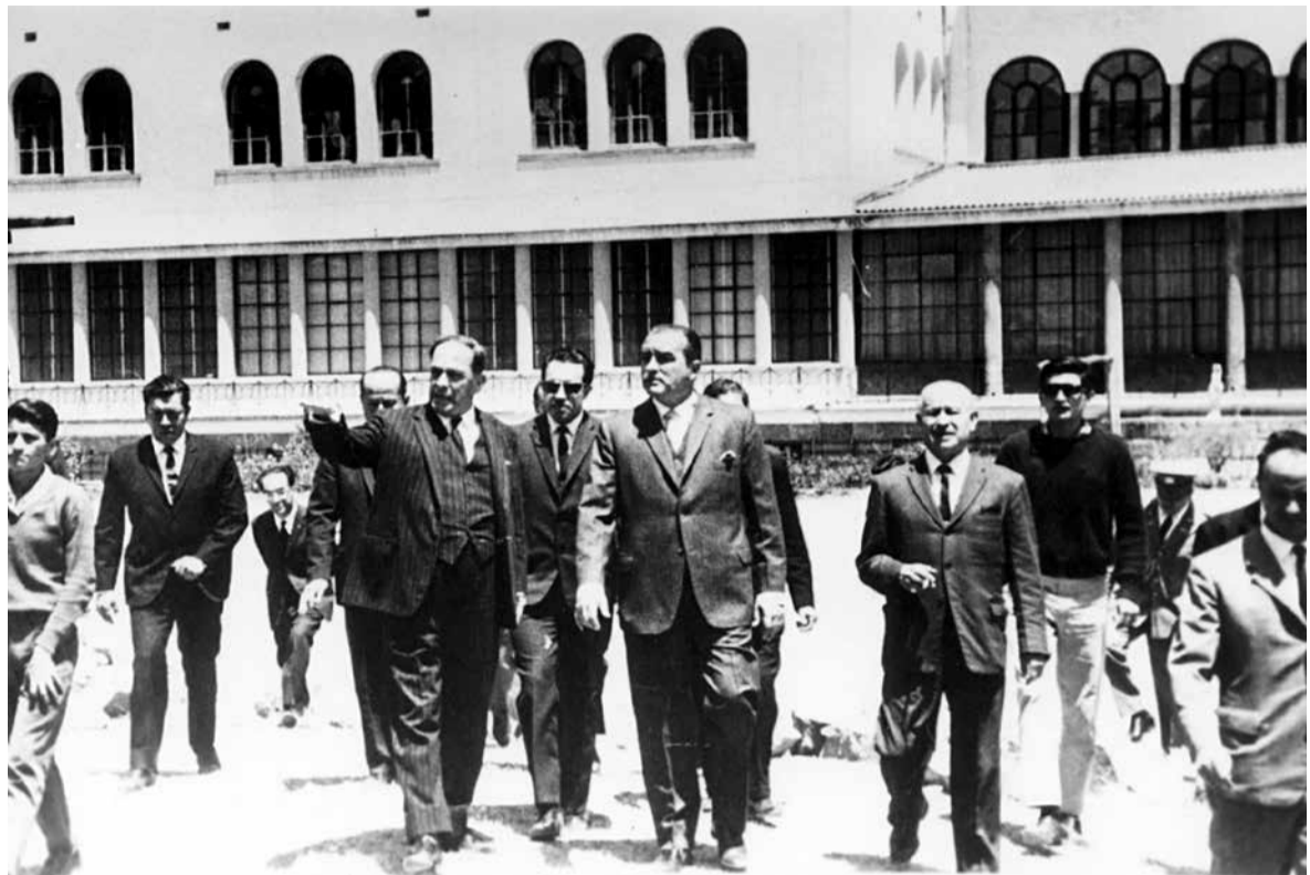
El presidente Otto Arosemena Gómez visita las obras de construcción de los nuevos edificios de la Casa de la Cultura. 26 de septiembre de 1967
