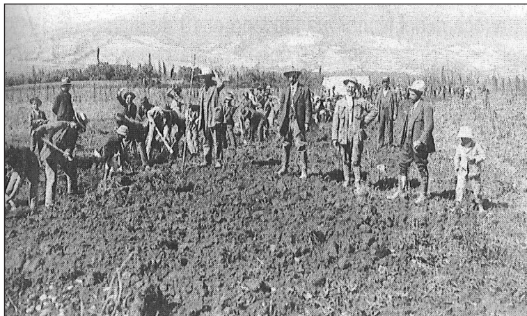
Una minga para la apertura del terraplén para el ferrocarril Ibarra-Quito, sección la recta Ibarra-San Antonio.
