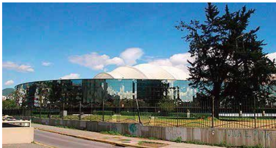
Ilustración 2. Foto "Edificio de Los Espejos" CCE
