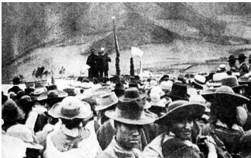
Nudo de Cajas en el límite de las provincias Pichincha e Imbabura. Instante trascendental en que se da lectura al acta respectiva, formalizando la adjudicación de los trabajos previos pro construcción de la línea férrea Quito-San Lorenzo ( archivo histórico del Municipio de Ibarra ).
