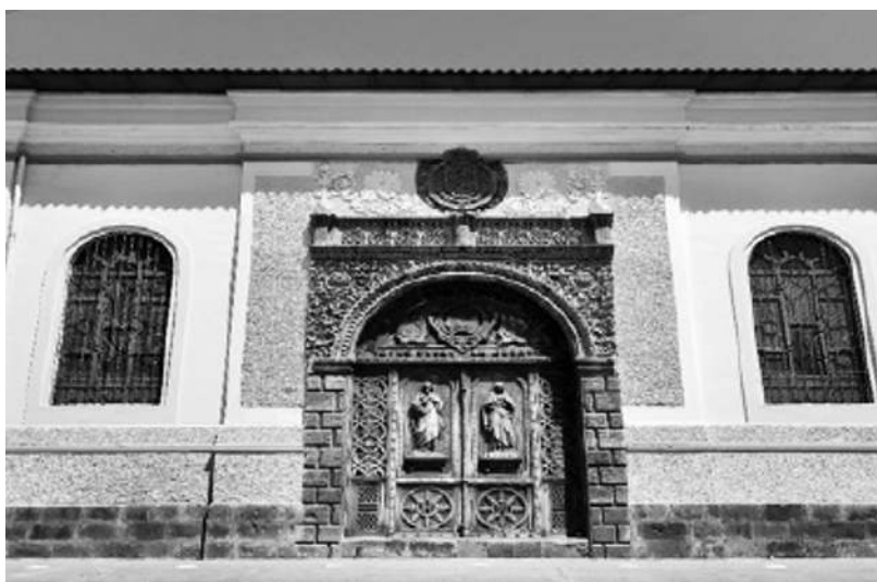
Portada de piedra del acceso lateral de la antigua iglesia de la Compañía que se empotró en la capilla del colegio Oviedo. La puerta de madera es ya del siglo XX. Foto: Pablo Rosero Rivadeneira
